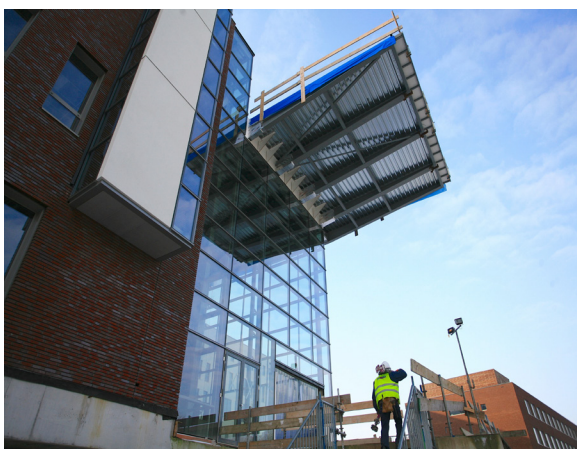
De bouw van het nieuwe ziekenhuis is in volle gang
